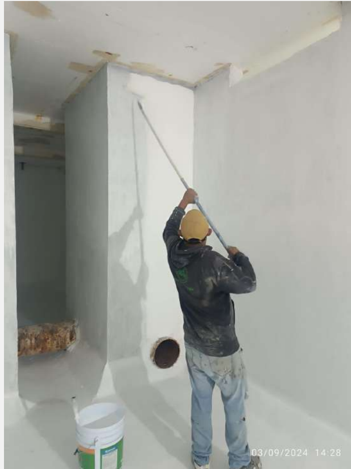
Reparación de la cisterna – sede circuito exterior
