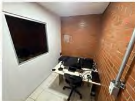
CUARTO DE CONTROL
