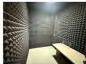
CUARTO DE REGISTRO 2
