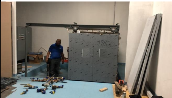
Instalación de nueva autoclave
