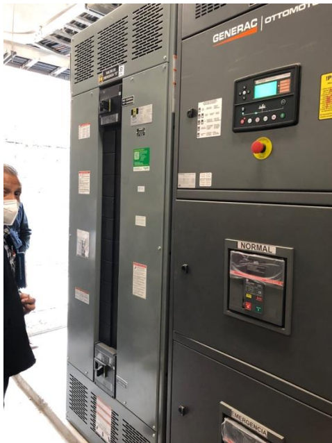
Nuevo tablero en subestación de baja tensión
