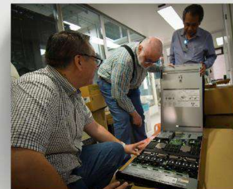
MEJORA A INFRA- ESTRUCTURA DE CÓMPUTO (Switch y servidores)
