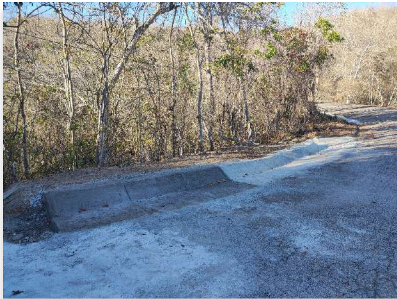
Albañilería de mantenimiento al desagüe del camino pavimentado y el terreno desnivelado que baja a la planta de emergencia
