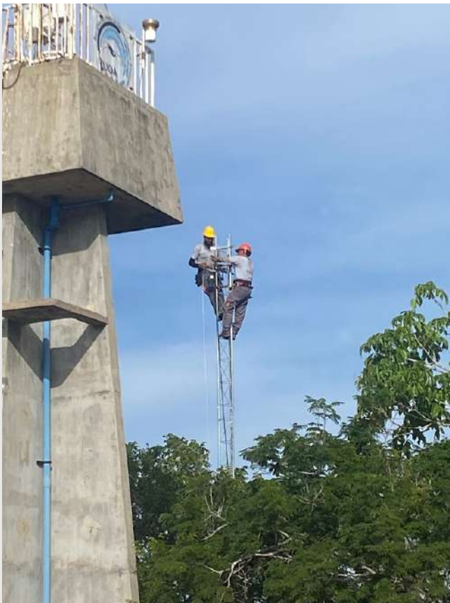
Instalación del pararrayos Preactron3 en la Estación Chamela
