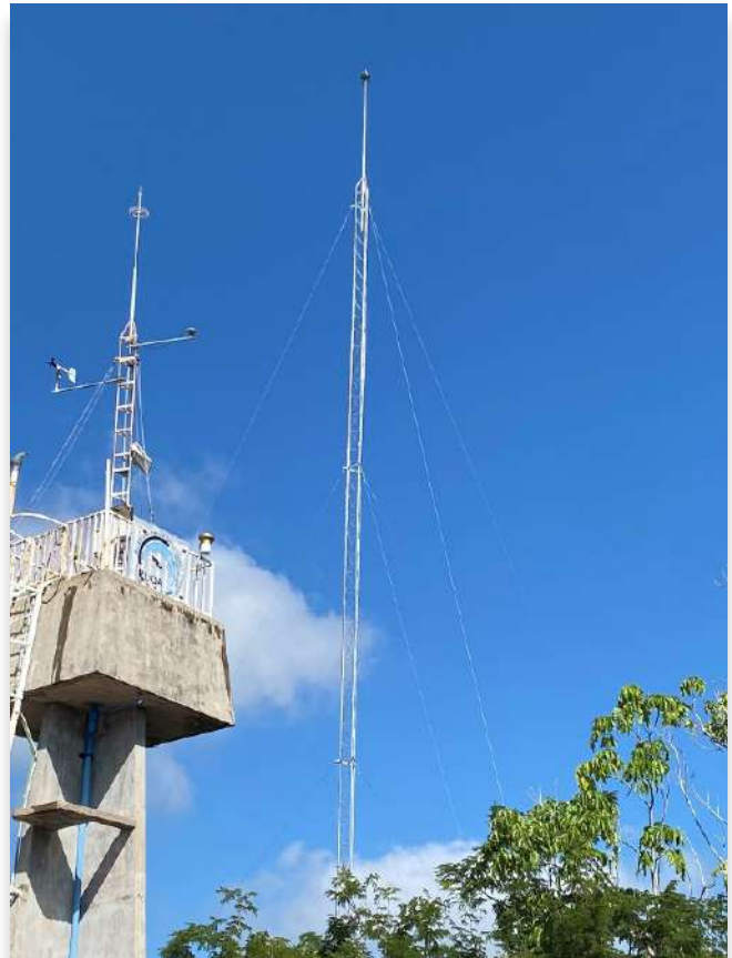
Instalación del pararrayos Preactron3 en la Estación Chamela
