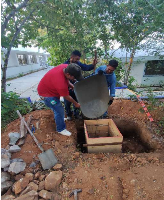
Fabricación de dados de retenida y dado central para torre de pararrayos
