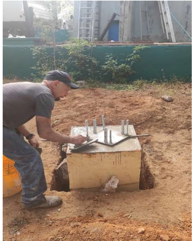
Fabricación de dados de retenida y dado central para torre de pararrayos
